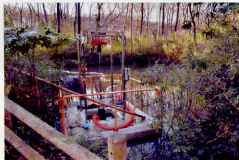
ふたつ池下池の浚渫
